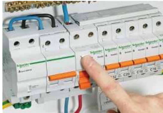
Obr.31. Proudový chránič , proudový chránič zapojený do skříňě s jističi
