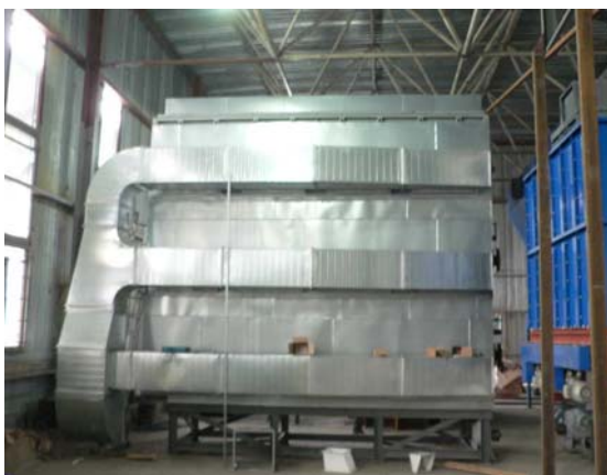
Obr. č. 8: Sušárna se šnekovým dopravníkem
